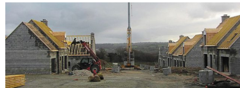
Les maisons en constructions actuellement en plein centre-bourg.
